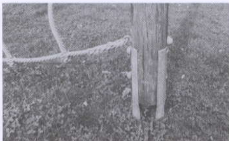
Nach einer sorgfältigen Überprüfung wurden Gefahrenherde wie dieser hier ausgemerzt.
