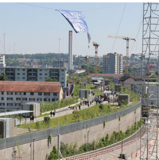
Auf dem Dach der Einhausung – neuer grüner Treffpunkt für Schwamendingen.
