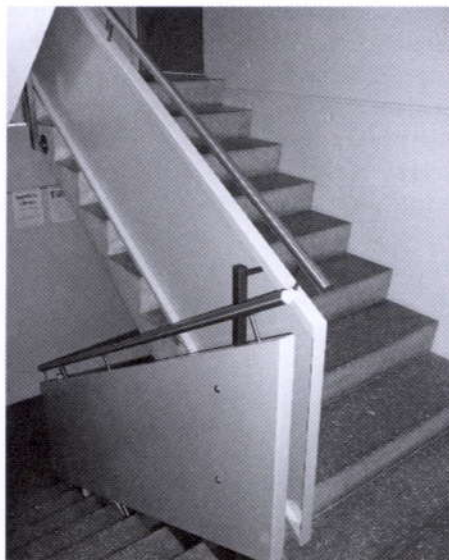
Neues Material, neue Fenster und frische Farben machen aus den Treppenhäusern ein Bijou.
