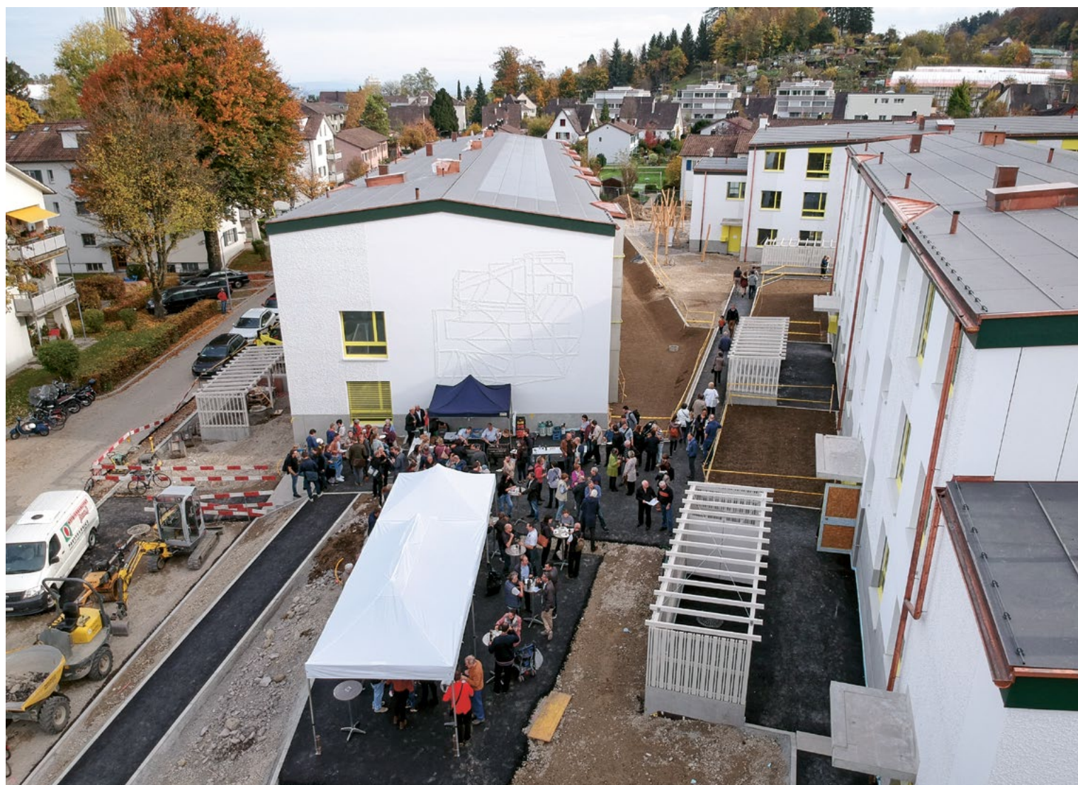
Der Neubau ist ein würdiger Nachfolger für die 21 Einfamilienhäuschen, die ihm weichen mussten. Das Wohnungsangebot auf dem Areal hat sich dadurch mehr als verdoppelt. Die Wohnungen werden etappenweise ab November 2017 bis Februar 2018 bezogen.
